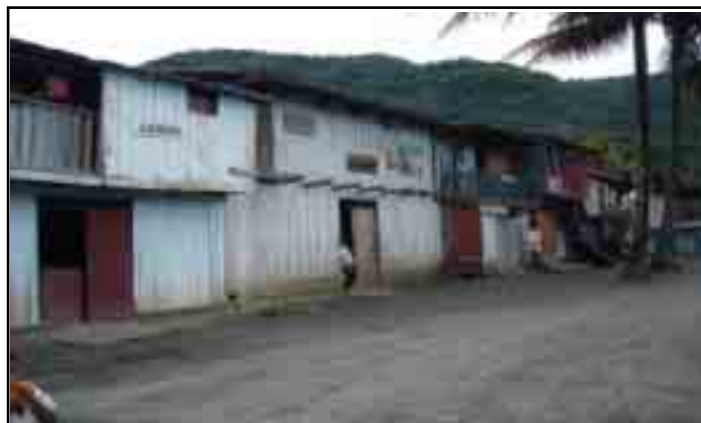
Foto N° 25: Viviendas Áreas Urbanas – Unión Progreso – Distrito de Anco.
